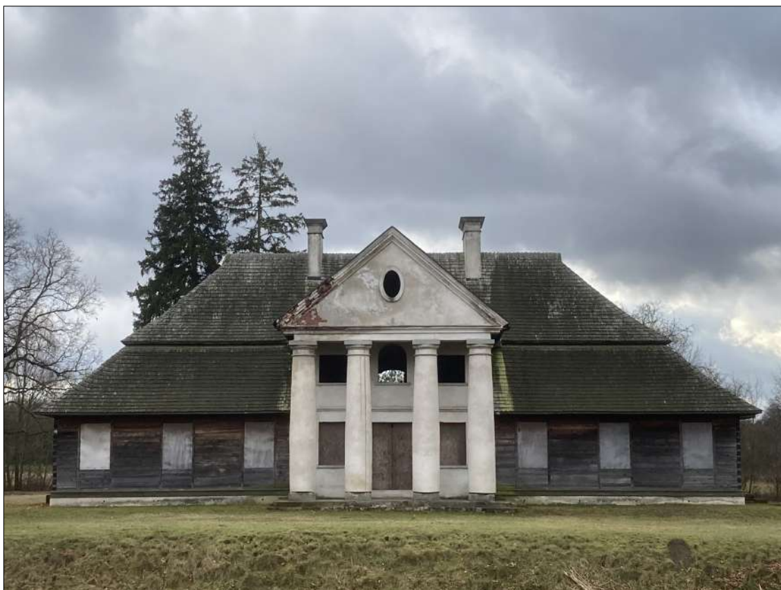
Dziewiętnastowieczny dwór w Wodzieradach, elewacja północna
