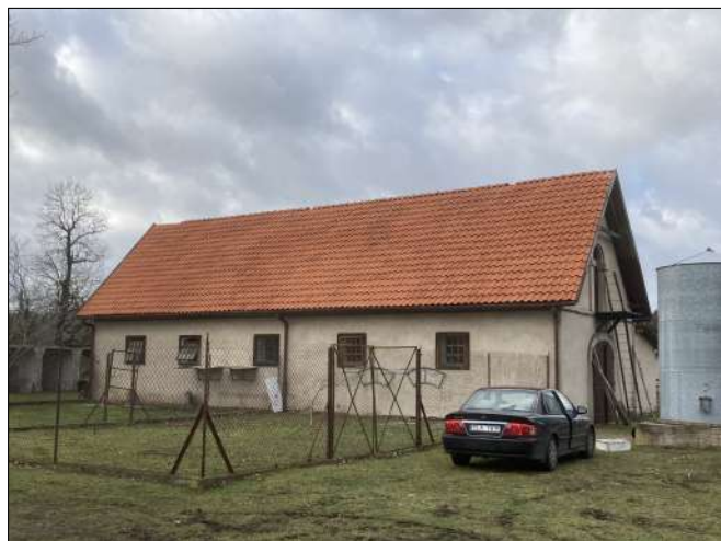
Budynek inwentarski (dawna obora). Fot. P. Pawlak
