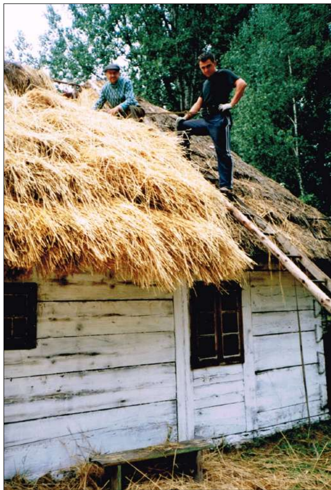
Kładzenie strzechy w sieradzkim skansenie przez Henryka Paśa z Grójca Wielkiego. Fot. B. Sośnicka
